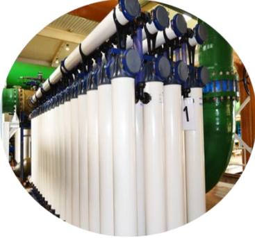
La planta desaladora de Accra Water utiliza membranas de ultrafiltración (UF por sus siglas en inglés) para el pretratamiento del agua. Este tipo de membranas cuentan con poros que permiten eliminar partículas que van desde 0,01 hasta 0,1  $\mu\text{m}$ . En el proceso de filtración, el agua puede pasar directamente a través de la membrana, siendo estos poros microscópicos los que permiten atrapar partículas y contaminantes no disueltos .
