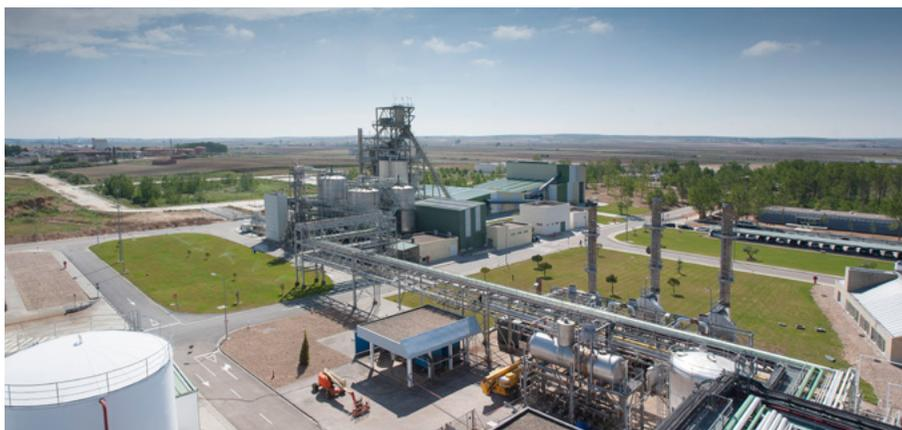
La ciudad de Salamanca suministra los RSU a la planta de demostración. Los residuos se separan y clasifican en sus diferentes fracciones: materiales ferrosos, no ferrosos, aluminio, plásticos, textiles y fibra orgánica. Posteriormente, la fibra orgánica se procesa para obtener etanol de segunda generación.
